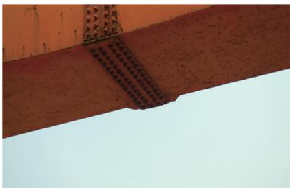
图4 主梁下盖板及法兰连接部位
