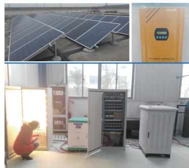
图9 太阳能制氢-金属氢化物储氢-氢燃料电池集成供电原理样机系统
