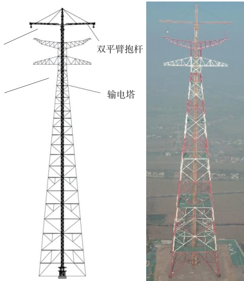
图1 大跨越输电塔(高 385 m)及双平臂抱杆
