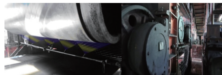
图3 现场光缆安装情况
