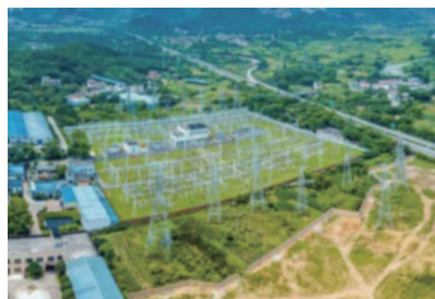
图3 电力线路全景图像
