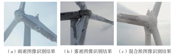
图 3 基于所提方法的风机叶片表面结冰类型输出
