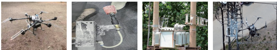
图10 无人机绝缘喷涂成套装置及喷涂成果
